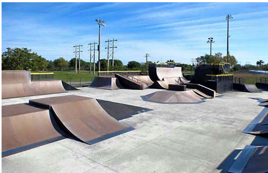
Рисунок 16. Пример покрытия площадки скейт парка железобетоном.
